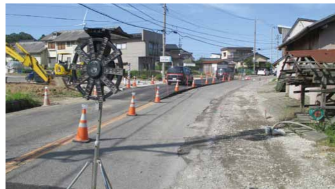
▲北潟305号線の冠水対策・道路高上げ工事(4か所)
