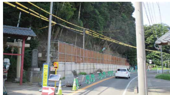
▲高塚の法面工事(県道・水口 - 牛ノ谷線、高塚春日神社ヨコ)
