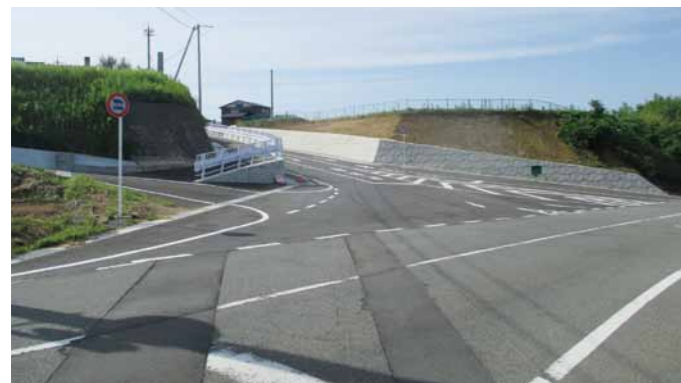
▲千束の嶺北縦貫道と赤尾 - 千束線の合流点工事
