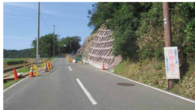
▲吉崎・細呂木間の法面対策工事とガードレール設置
