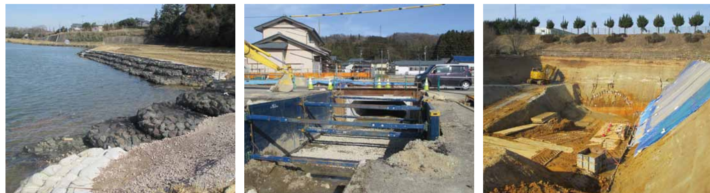
▲北湯湖の鷺の浦湖岸補強工事 ▲山室 - 菅野雨水幹線工事(菅野) ▲北陸新幹線・柿原トンネル工事(柿原)
